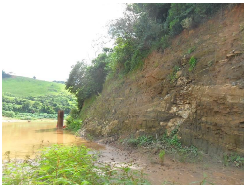
Foto 7 – Talude de escavação da ombreira direita logo a montante do eixo do Barramento B. Rocha gnáissica alterada na base e solos residuais no topo
