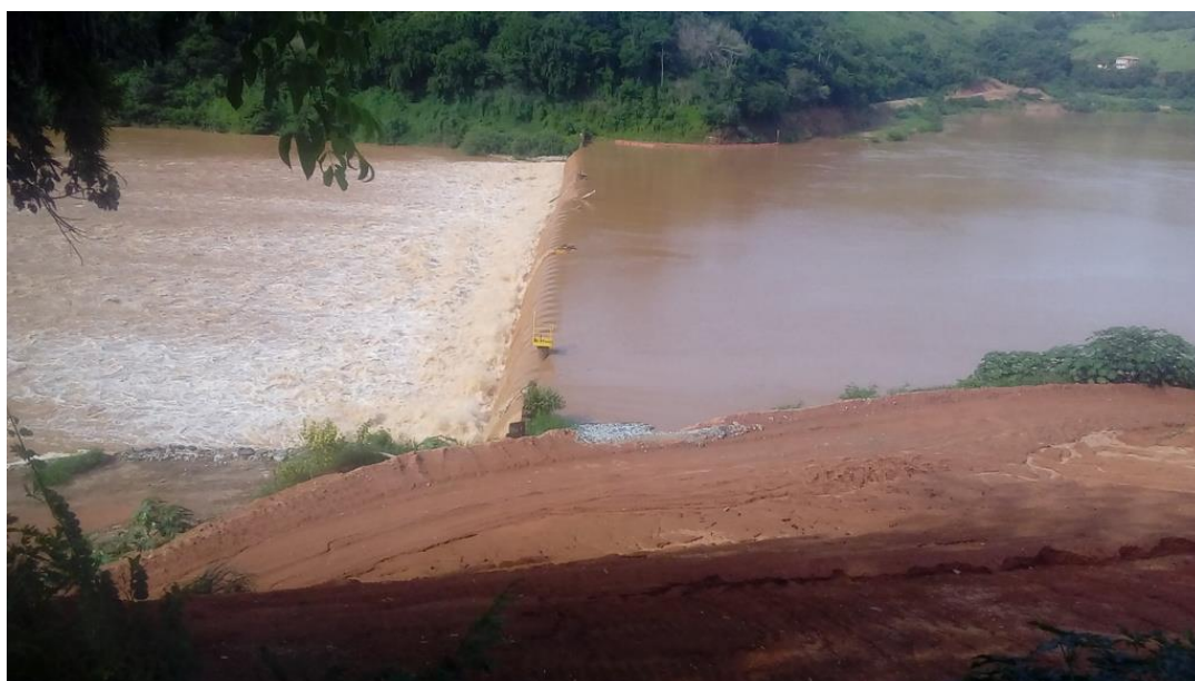
Foto 3 – Ombreira esquerda do Barramento B – Ravinamentos no terreno por deficiência de proteção
