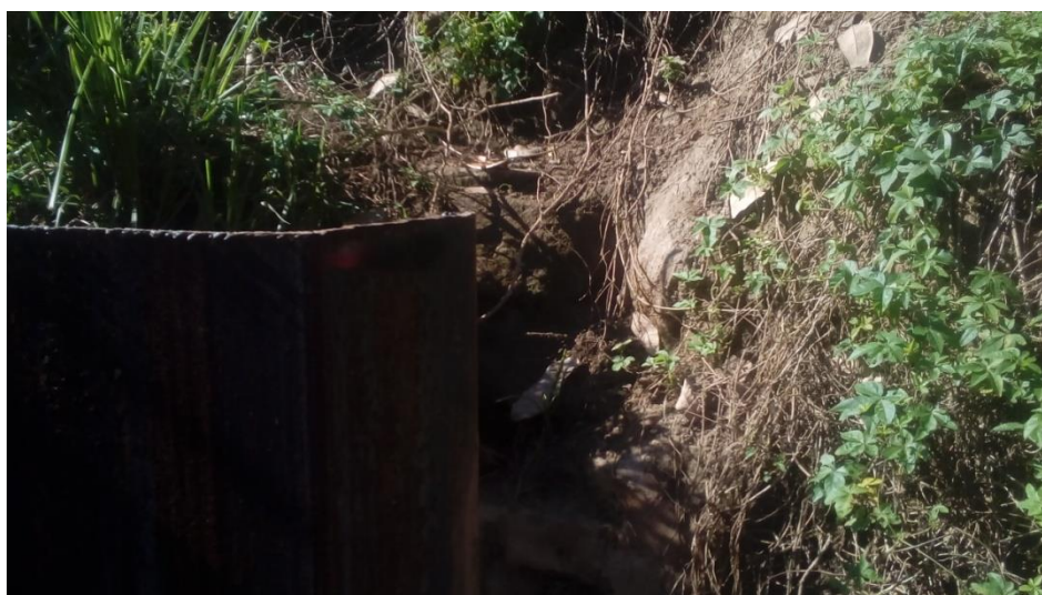
Foto 8 – Vista de montante do vão aberto situado entre a última estaca prancha do Barramento B e o talude da margem direita.
